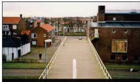
Trap op de dijk van 't Nieuw Tjiftvondig
