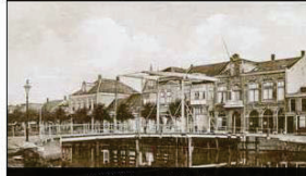
De Holerbrug aan de Kanaalweg
